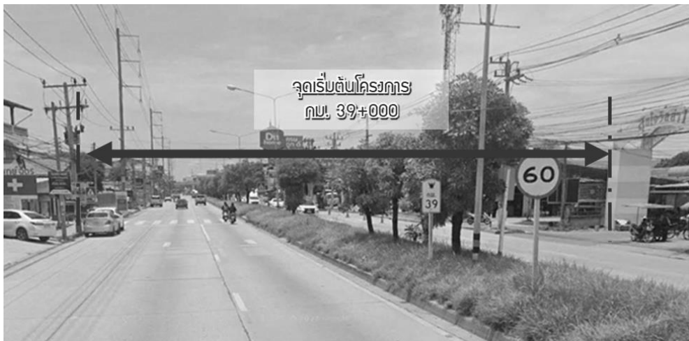
รูปที่ 4-3 ถนนบริเวณจุดเริ่มต้นโครงการ
