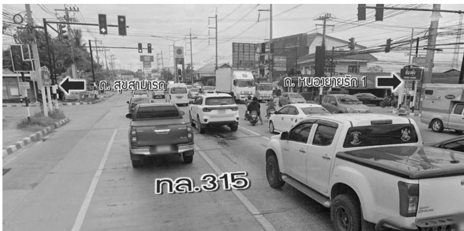
รูปที่ 4-6 ทางแยกเชื่อมระหว่างทางหลวงหมายเลข 315 กับถนนหนองยายรัก 1 และถนนสุขสามารรถ (ทางแยกท้องคู้ง)
